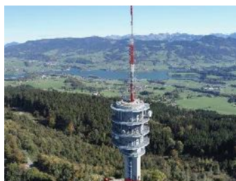
Antenne du Gibloux
